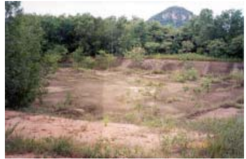
รูปที่ 4 บ่อน้ำที่ขุดบริเวณพื้นที่สูงและเป็นดินทราย แม้การก่อสร้างจะตาดด้วยซีเมนต์แต่ไม่สามารถเก็บกักน้ำได้
