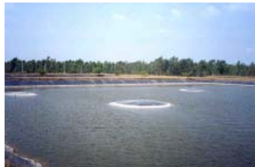
รูปที่ 5 การปูด้วยแผ่นพลาสติกกันซึม บ่อพักน้ำเสียพื้นที่ที่เป็นดินทรายของศูนย์กำจัดขยะเทศบาลเมือง ศรีราชา จ.ชลบุรี
